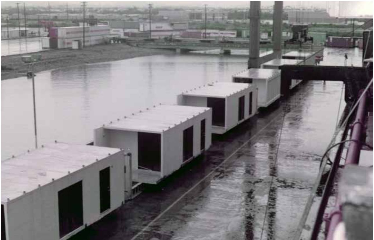
Embarcando módulos prefabricados para un hotel en Aruba, 14 de mayo de 1983
