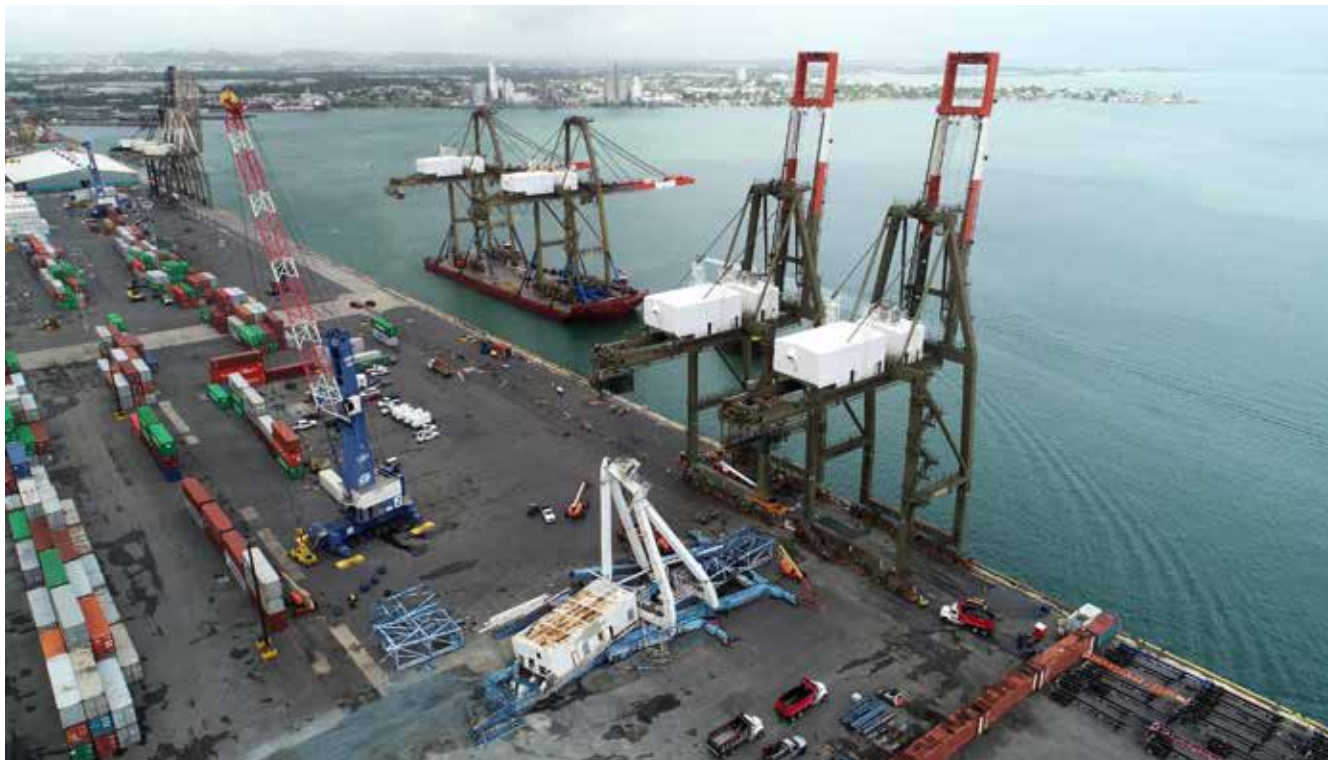
Llegada de las grúas Paceco, Formato Panamax de 65 toneladas de capacidad, adquiridas en 2019, comienzo de su instalación, y demolición de la grúa número 7, en el Terminal de San Juan
