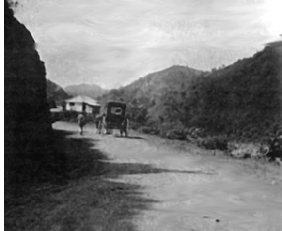
Carretera de San Juan a Ponce "La Piquiña" a finales del siglo XIX
