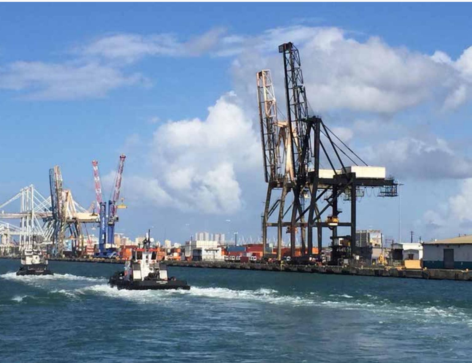
Terminal en San Juan, 2018
