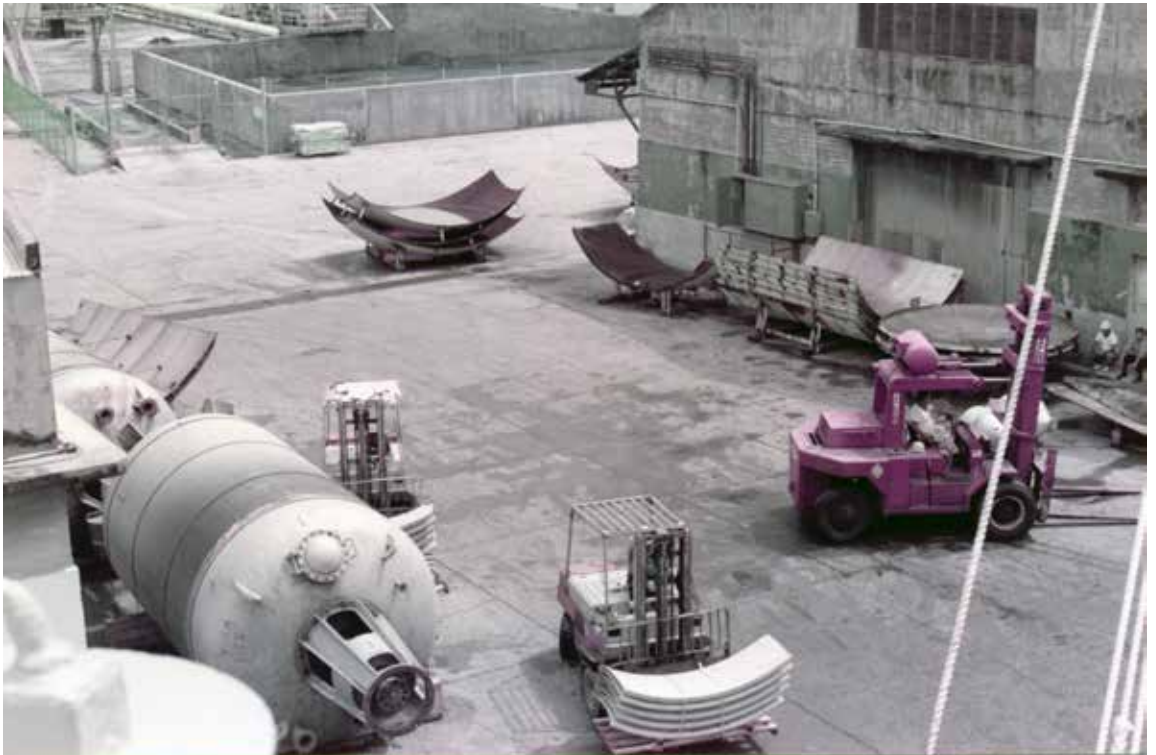
Piezas desmontadas de la Central Rochelais de Mayagüez y enviadas a Cali, Colombia
