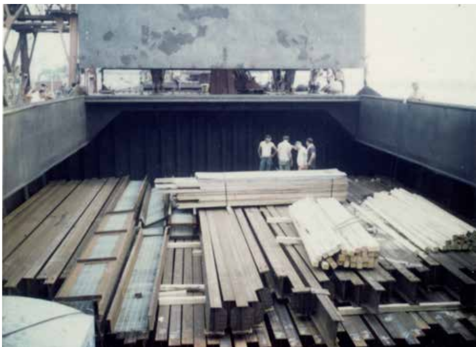
Descargando tres barcas que trajeron las piezas de US Steel Corporation para construir los puentes de la Autopista Las Américas de Ponce a San Juan en 1975, hoy PR 52, Autopista Luis A. Ferré
