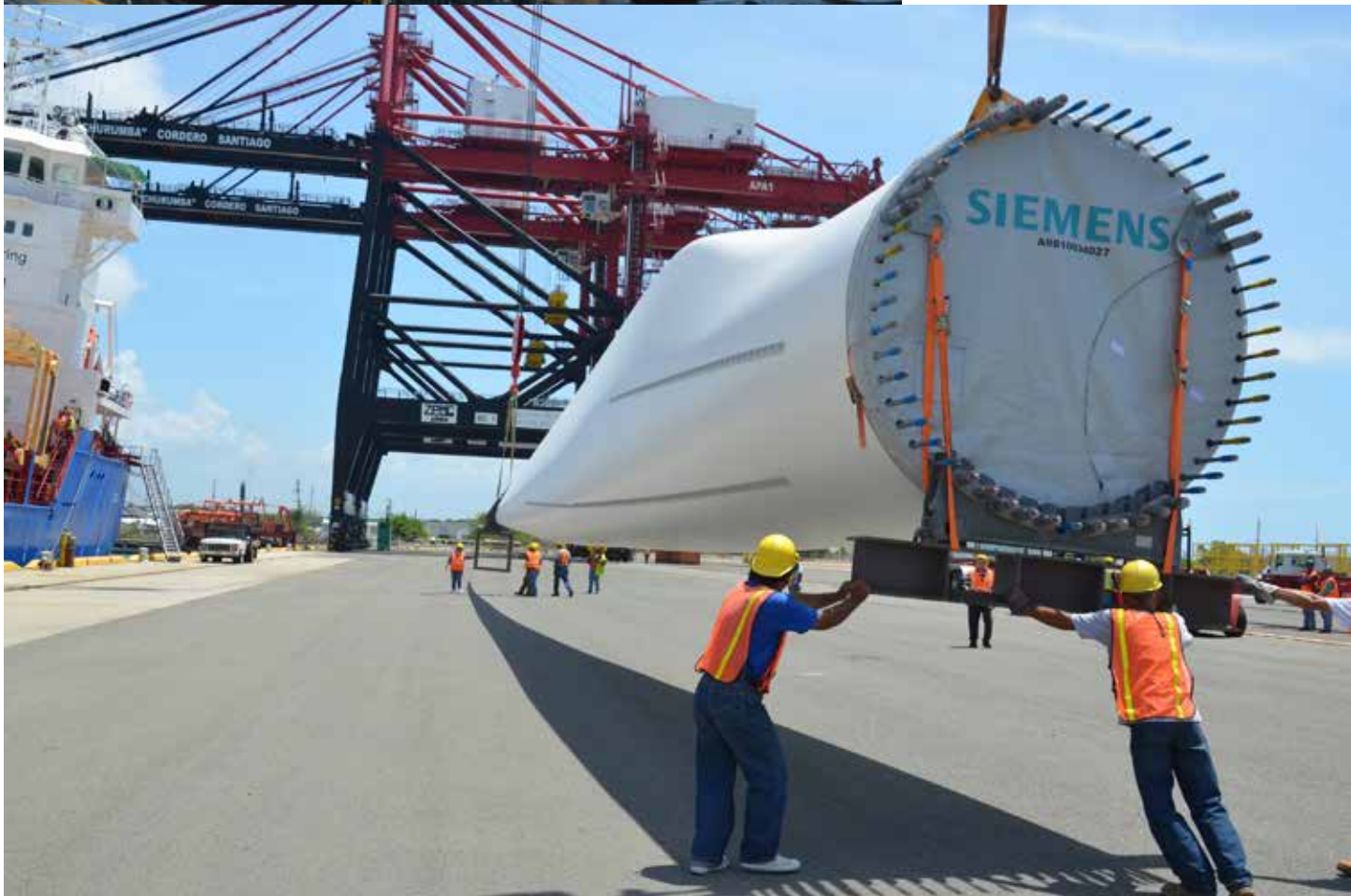
Aspas de los molinos de 157 pies de largo y peso de 12 toneladas
