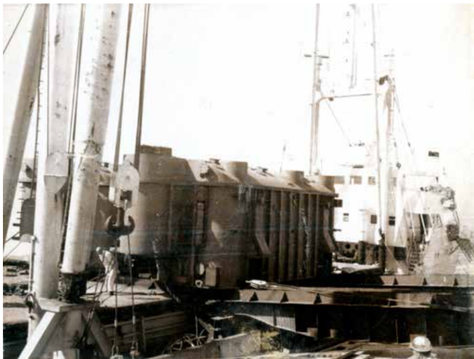
Proyecto Central Termoeléctrica del Sur en Guayanilla, 1974 Descarga de piezas de peso bruto de 220 tone- ladas del MV Belatrix, de BigLift, Amsterdam, Holanda vía el Muelle de la Union Carbide en La Puntilla, Guayanilla
