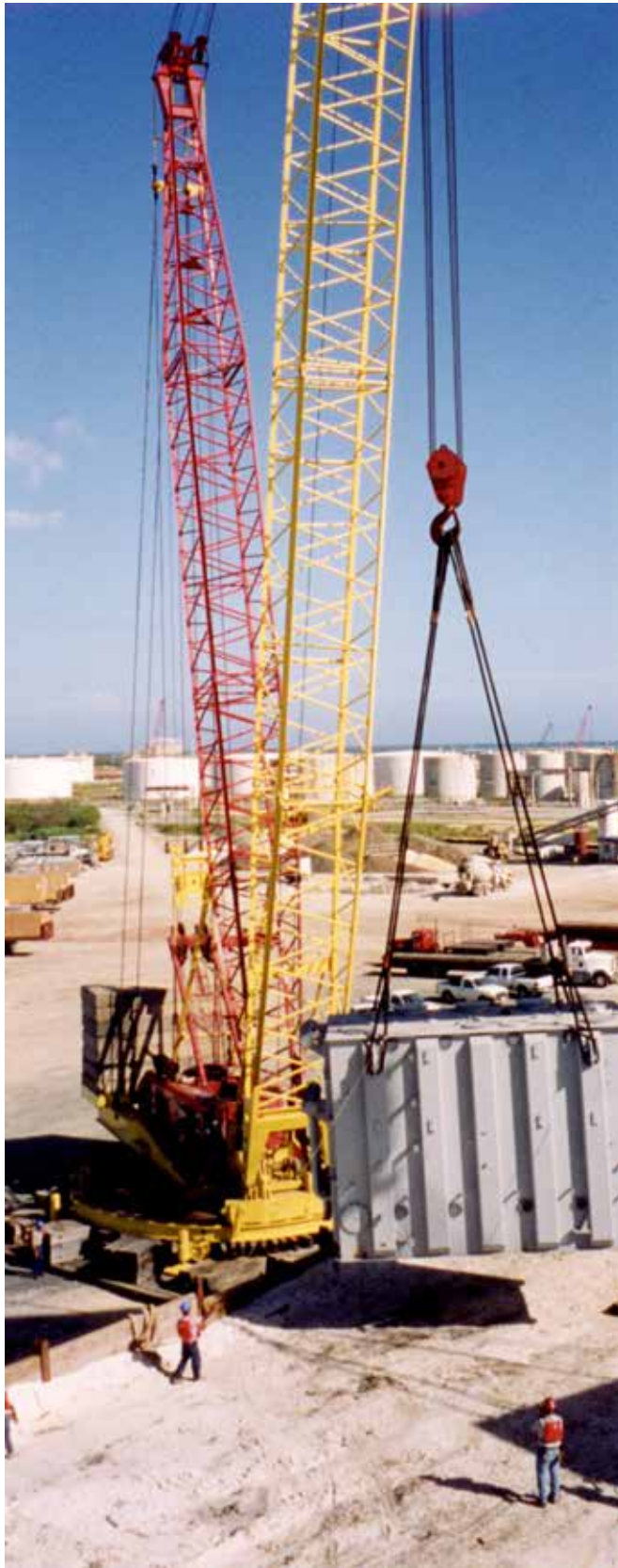
Descarga en el Puerto de Guayanilla de equipo y materiales para la construcción de Planta Eco Eléctrica para la producción de gas natural, en contrato de Enron a Luis A. Ayala Colón, Sucrs., Inc., en 1999
